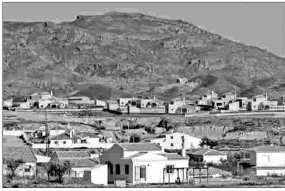
Demolición de 20 viviendas ilegales
